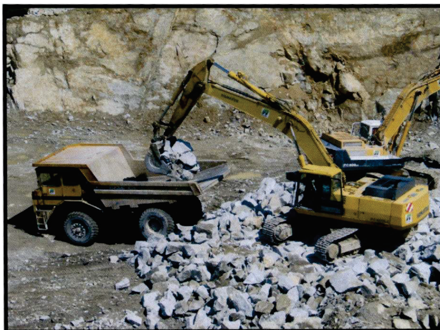
Fotografia nº 3: Operação de carregamento do dumper junto à frente da pedreira
